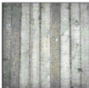
Variazioni di colore sulla superficie in evidenza poche ore dopo la rimozione delle casseforme
